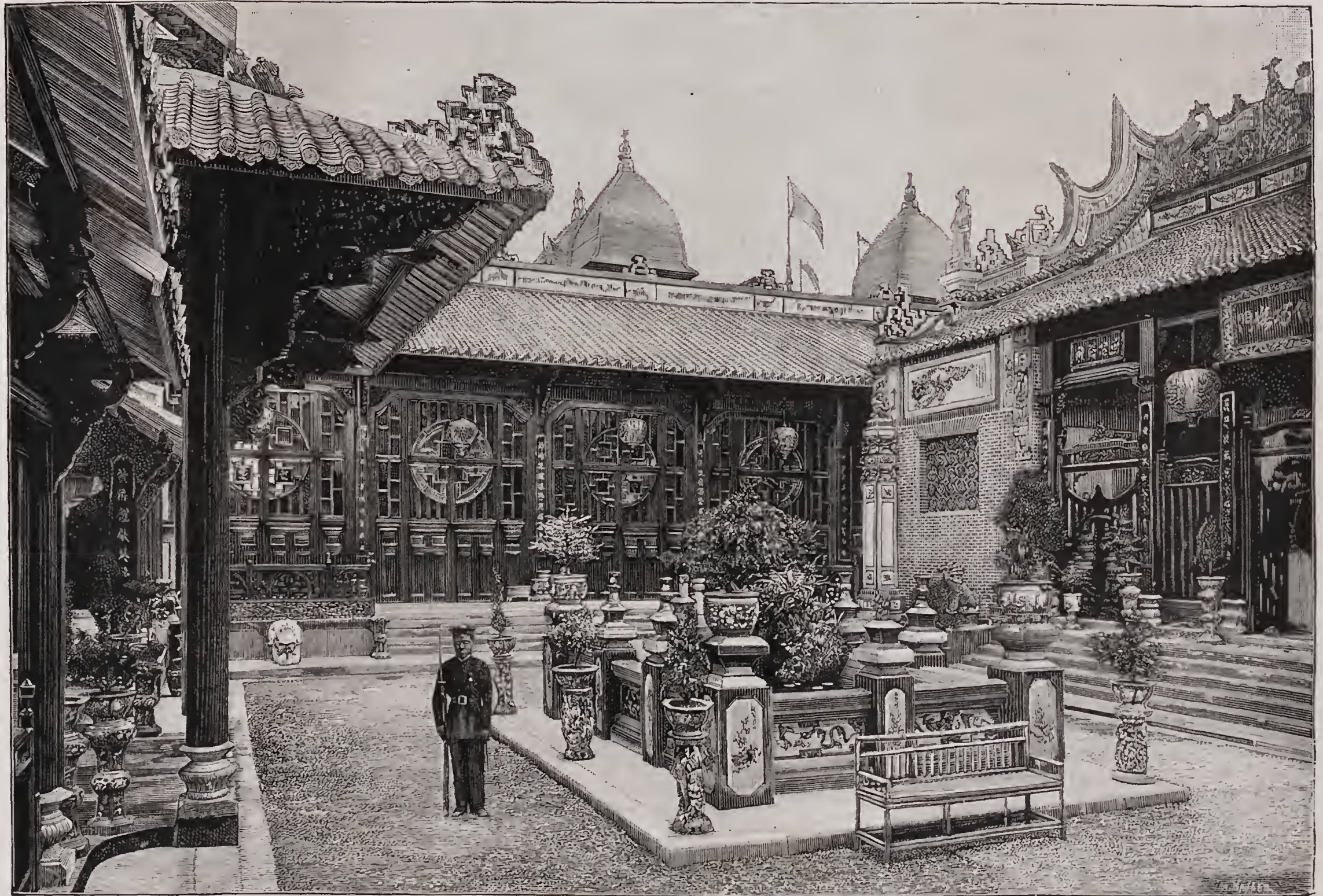
COUR INTÉRIEURE DU PALAIS DE LA COCHINCHINE.
